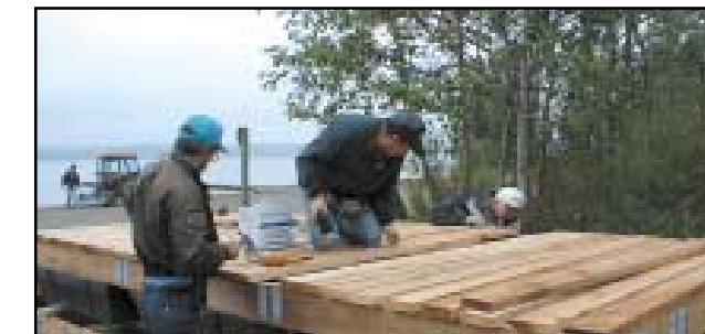
Illustration 5-15 Remplacement des quais à l'anse Boat
