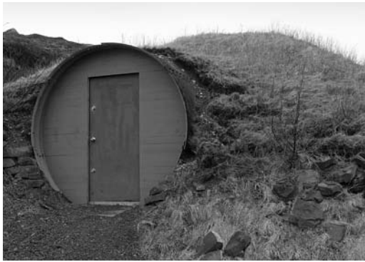
Abri Quonset de la Seconde Guerre mondiale. Don Parsons 2006
