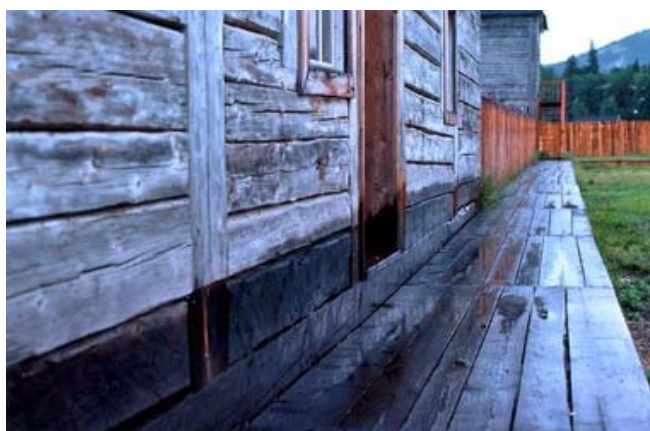
La pluie éclabousse les rondins inférieurs de l'entrepôt de fourrures. Photographe : Bob Grill
